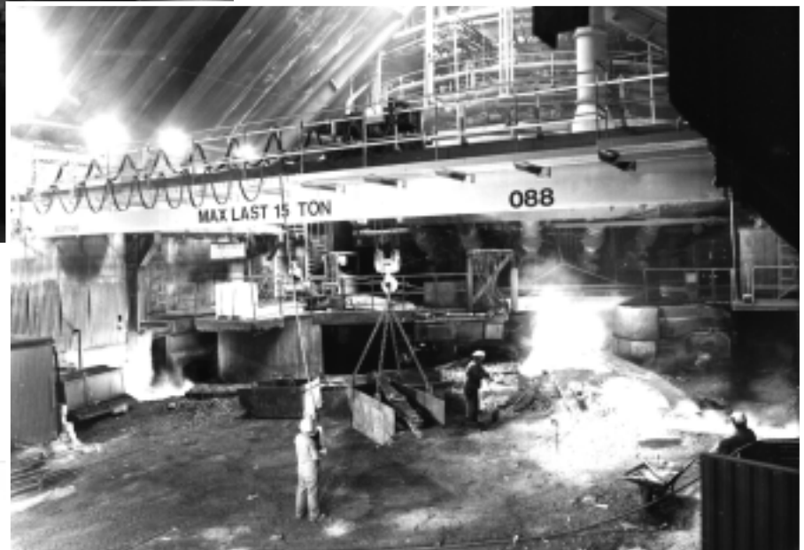
1-balks traverskran med vinkeltralla för 15 tons last. Lösningen krävdes för att lyft skulle kunna ske tillräckligt nära masugnen.
