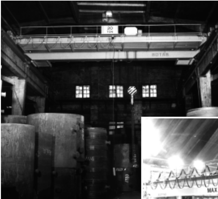
Traverskran typ RT-2 för 20 tons last vid 10 m spännvidd.
